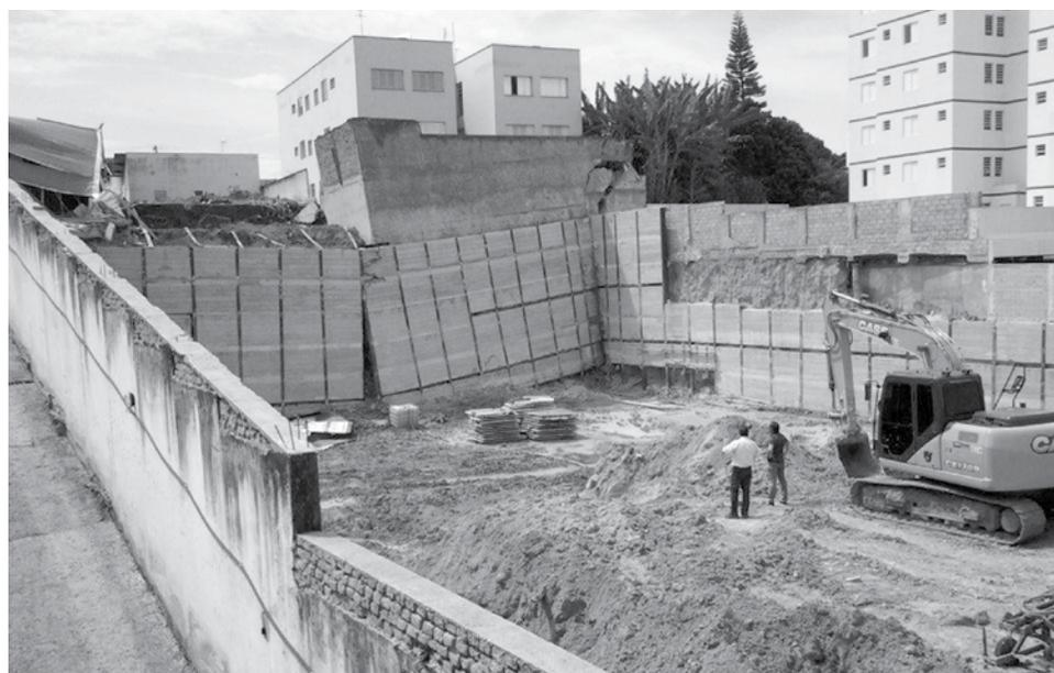
Muro de arrimo da construtora Ergplan cedeu cerca de 80 centímetros
