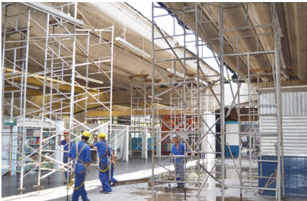
O escoramento das telhas que pesam de 8 a 11 tonelada cada uma foi colado em xeque
