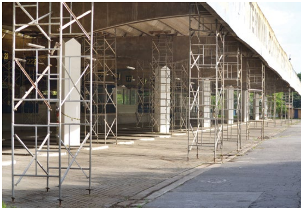
Plataforma de embarque com as escoras que deverão sustentar as telhas
