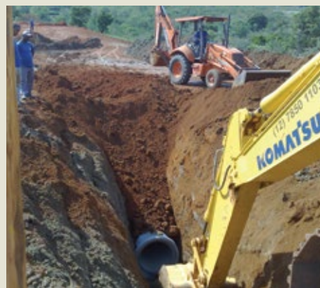
Construção da rede de água do empreendimento Cataguá Way
