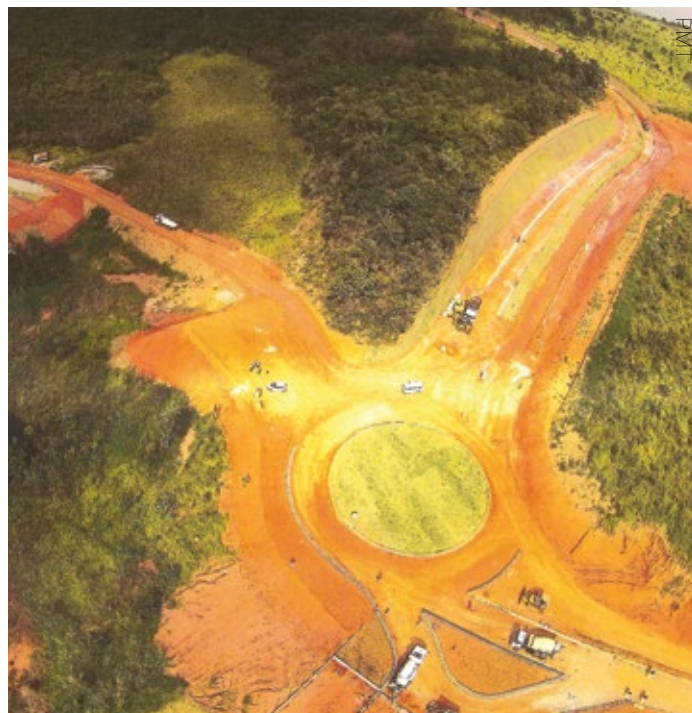
Obras de infraestrutura no Piracangaguá sem custo para a Prefeitura
