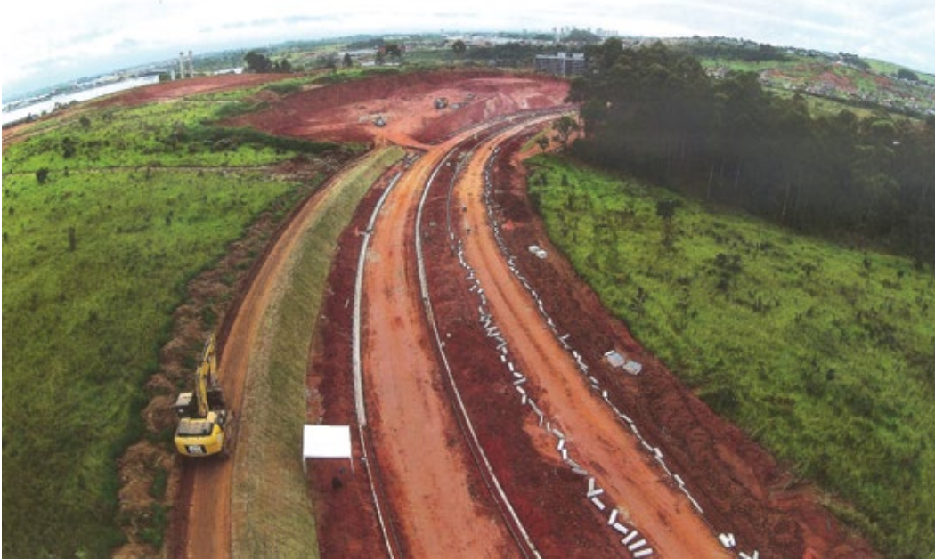
Prolongamento da avenida Virgílio Cardoso Pinna, no Piracangaguá, construído pela iniciativa privada
