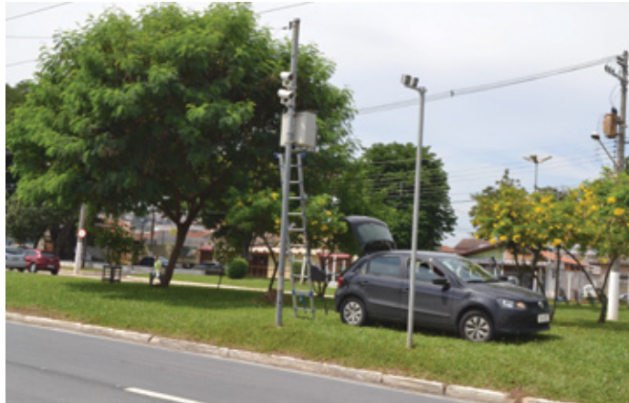
Acima, veículo da empresa responsável pela manutenção dos radares. Abaixo, reprodução da multa recebida indevidamente pelo 3º Sargento PM Paulo Roberto de Andrade
