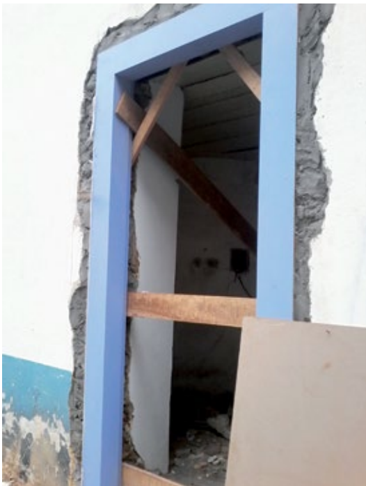
Imagens que comprovam a irresponsabilidade de autoridades civis e eclesiásticas na reforma da Capela do Pilar onde permitiram o uso de cimento sobre paredes de taipa originais
