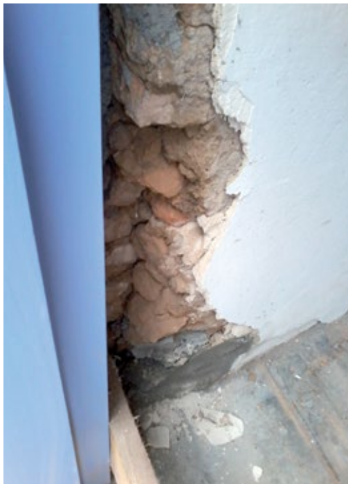
Imagens que comprovam a irresponsabilidade de autoridades civis e eclesiásticas na reforma da Capela do Pilar onde permitiram o uso de cimento sobre paredes de taipa originais
