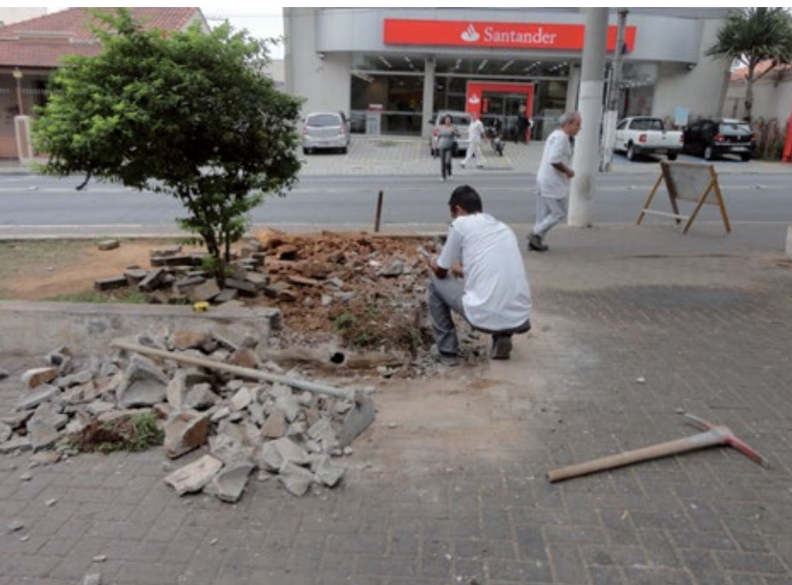
Funcionário da Prefeitura demolindo a mureta para facilitar a entrada do carrinho de lanches
