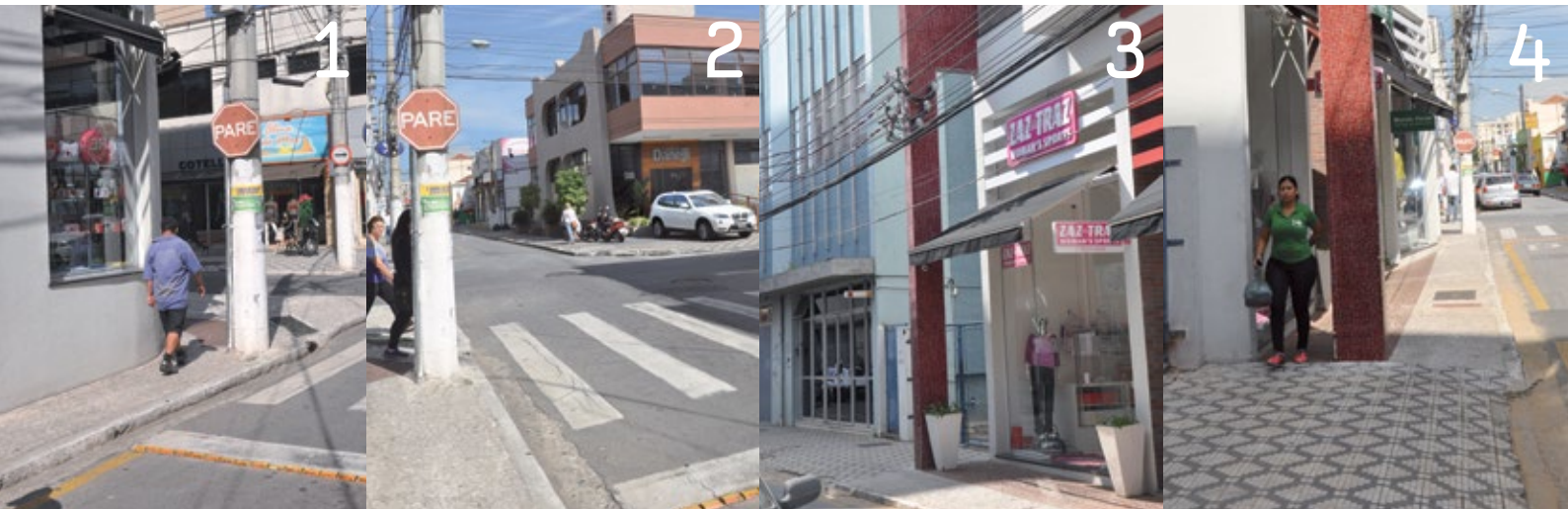
1- O prédio avançou sobre o espaço público de forma escandalosa... 2- ... os agentes econômicos do ramo se calaram... 3- ... tudo foi desrespeitado, no detalhe, a única exigência da prefeitura... 4- ... para dar passagem para um pedestre
