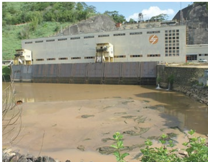
Usina Elevatória de Santa Cecília onde é feita a transposição de águas do rio Paraíba do Sul para o rio Piraí
