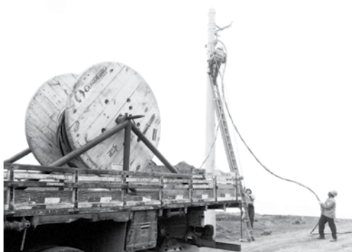
Obras de eletrificação no Cataguá Way, executadas pela Guisard Empreendimentos
