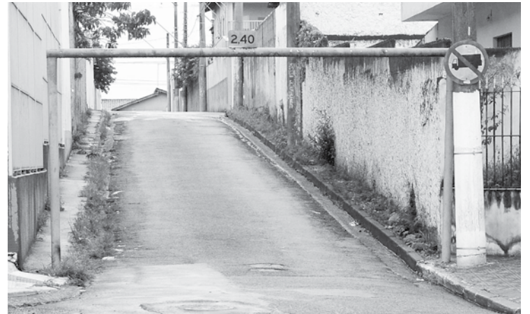
Limitador de altura implantado em travessa da av. Assis Chateaubriand, próximo da rua Irmã Luísa Basília
