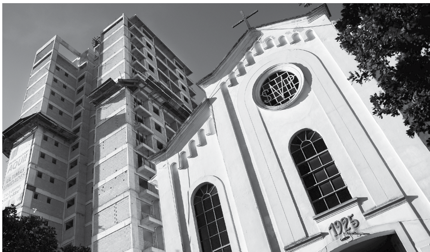
Empreendimento imobiliário oferece risco para a estrutura da capela
