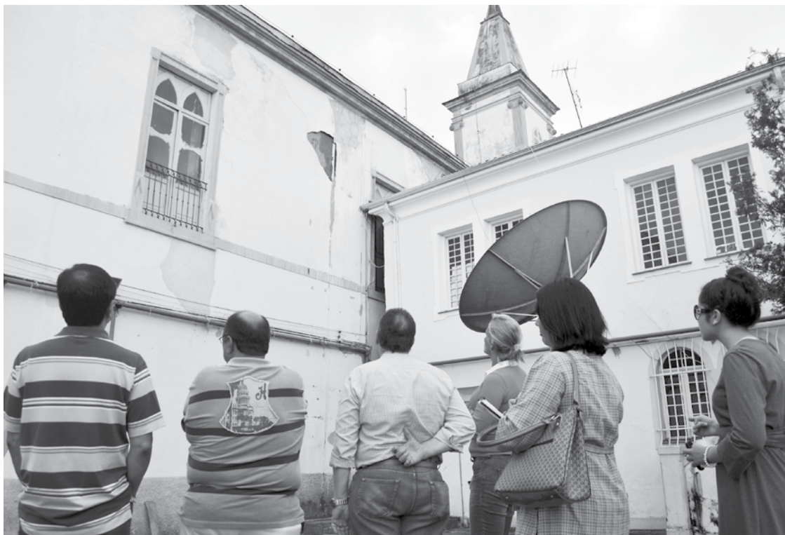
Cúria acompanha vistoria feita por engenheiros à Igreja do Rosário e seu entorno
