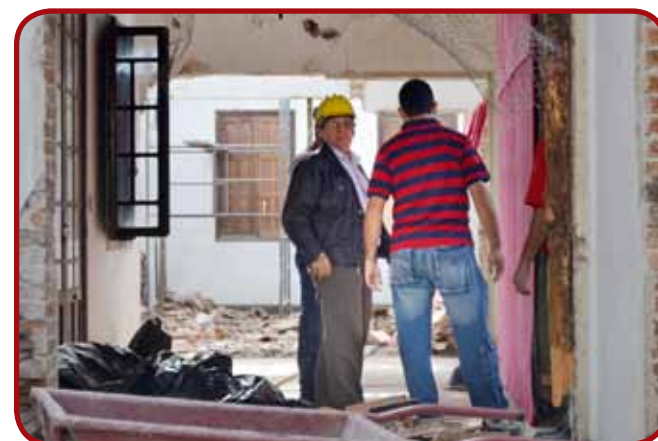
CONTATO flagra Carlos Rodrigues na obra que destruiu mais um patrimônio histórico em Taubaté
