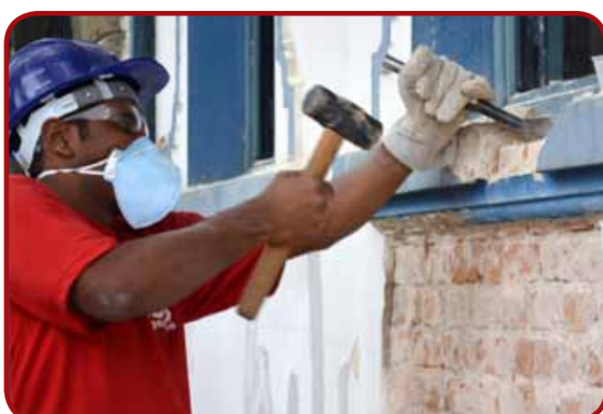
Pedreiro capricha na marretada para arrancar as bordas das janelas
