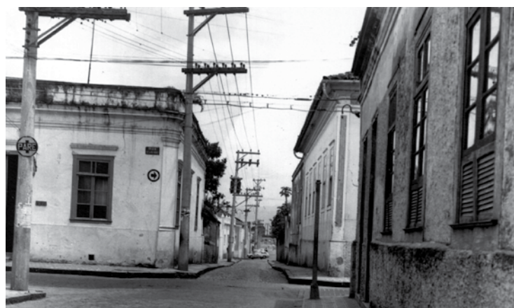
Casa de Cesidio e Lygia. No fim da década de 1990, infiltrações derrubaram o imóvel (acervo pessoal Lygia Fumagalli Ambrogi)
