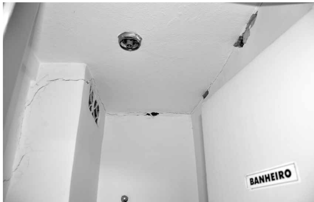
As fotos acima mostram a fachada do prédio e a piscina cheia de água. Abaixo, as rachaduras são visíveis e estão presentes nos dois extremos da parede do banheiro. O chão também apresenta uma delas.
