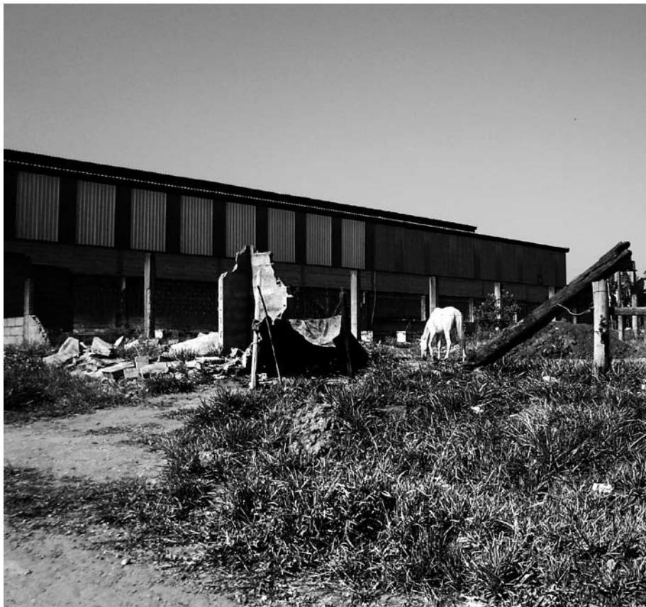
Sujeira, mato alto, entulho e até um cavalo foram encontrados na diligência promovida pelo CIESP
