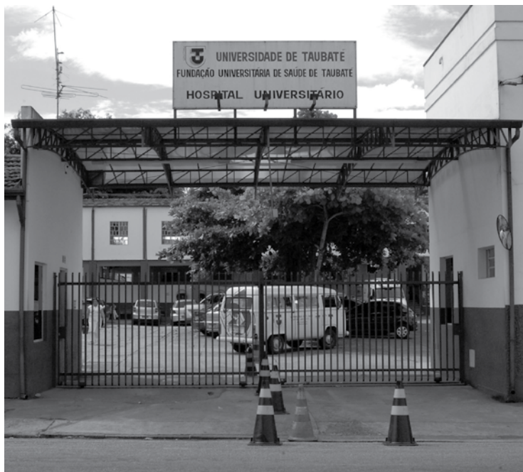
Fachada do Hospital Universitário
