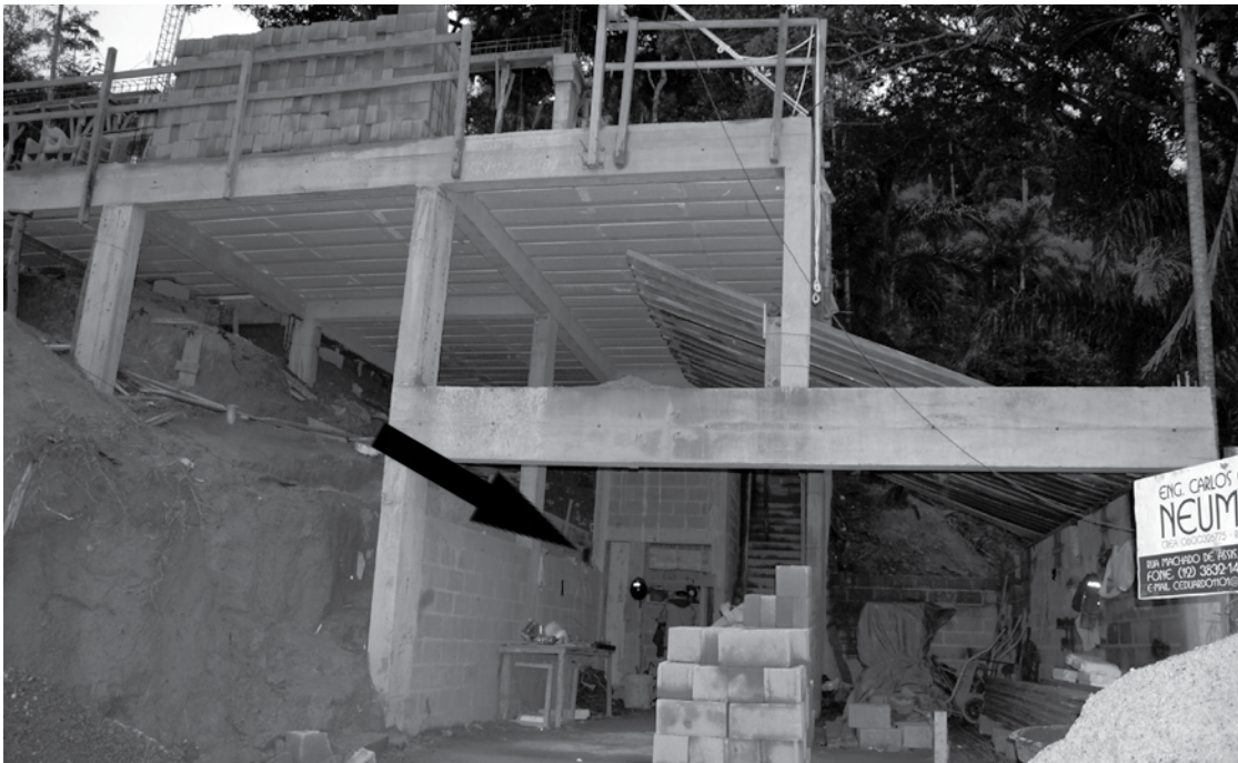
Seta indica o espaço reservado na construção para a instalação de um elevador
