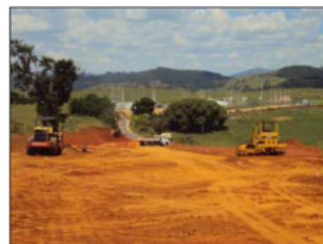
Obras estão em ritmo acelerado
