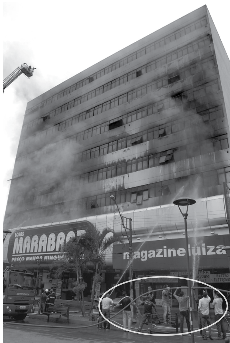
Prédio em chamas na praça Dom Epaminondas na quinta-feira, 3
