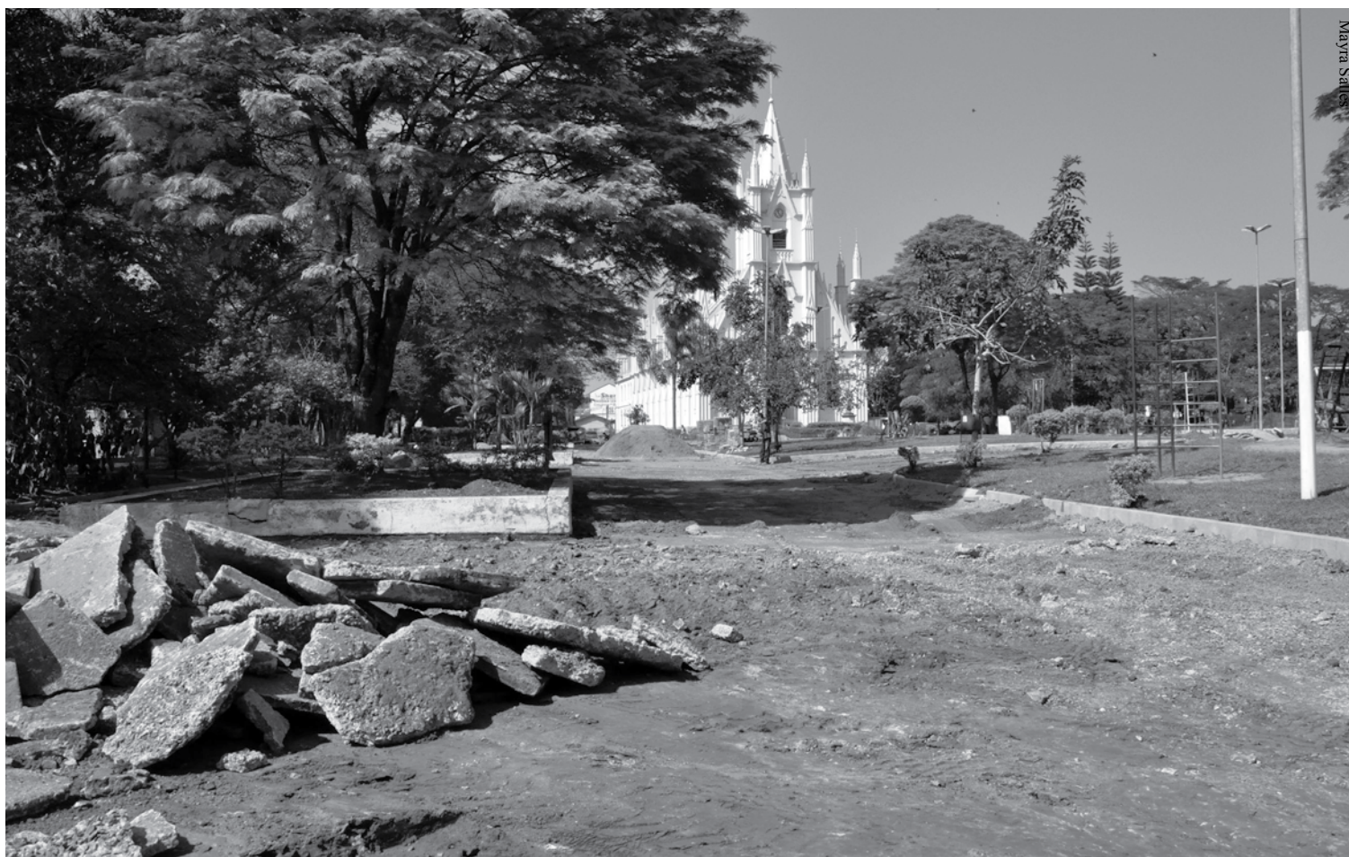
A Praça Santa Terezinha em obras: ninguém sabe e ninguém viu o projeto que está sendo executado
