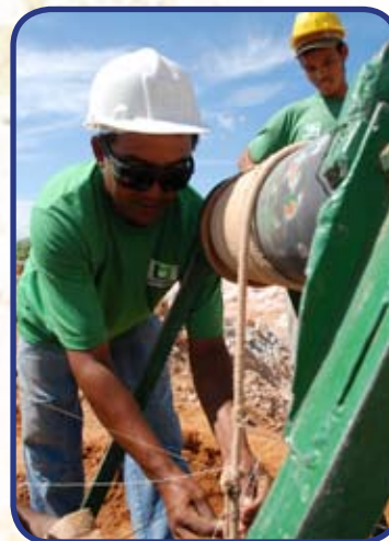
Vie Nouvelle em obras
