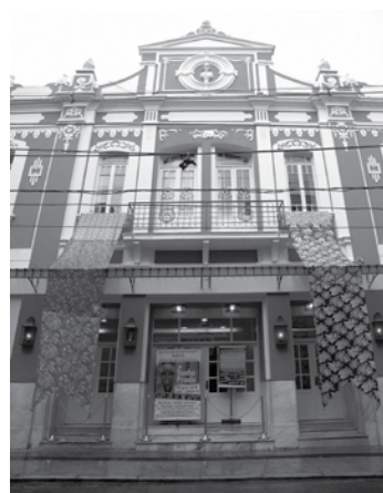
Fachada do Teatro Metrópole
