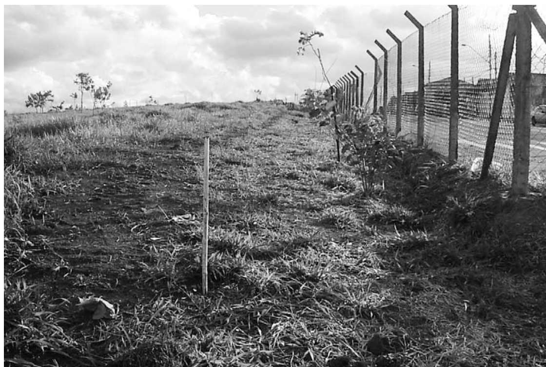
Ao centro, o piquete utilizado para demarcar o lote onde seriam construídas as casas
