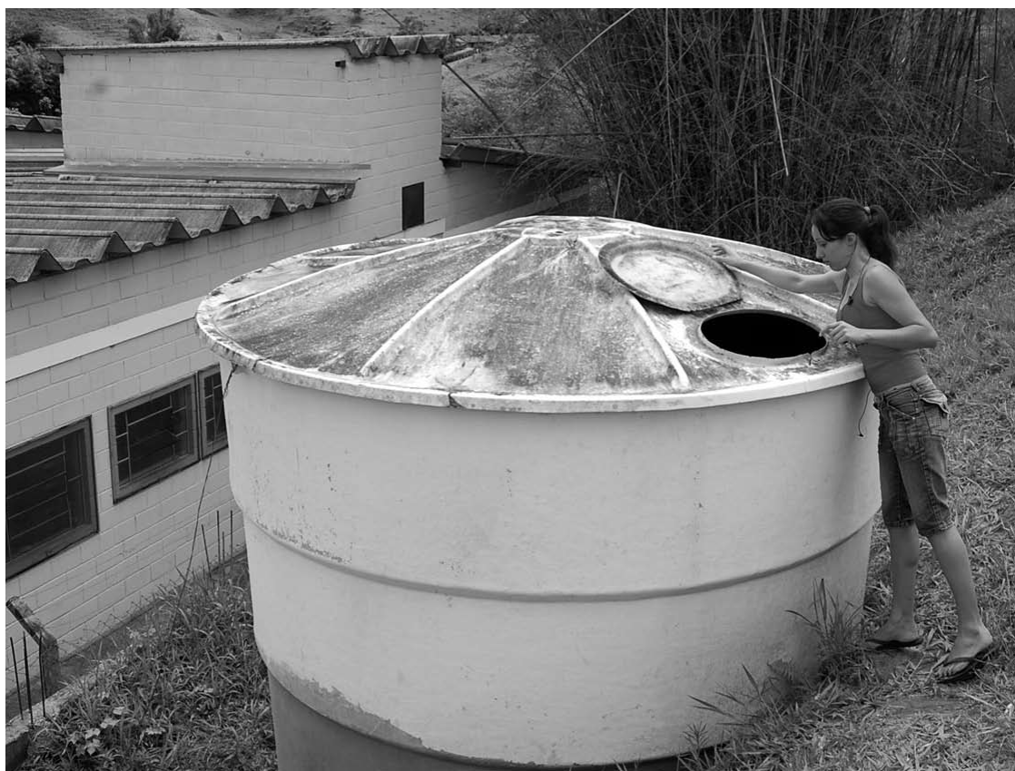
Moradora abre a tampa do reservatório de água. Sem proteção nenhuma e de fácil acesso até mesmo para crianças
