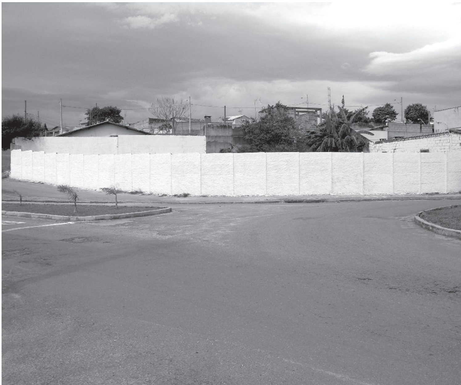
Muro construído por uma moradora do bairro. A iniciativa desagradou os demais. Os descontentes acham que a moradora pretende tomar posse do terreno que é público
