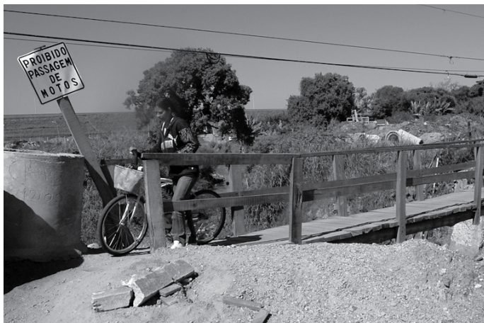
Moradores passam pela ponte improvisada
