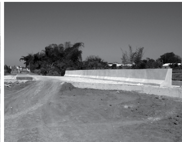
Nova ponte em fase de acabamento
