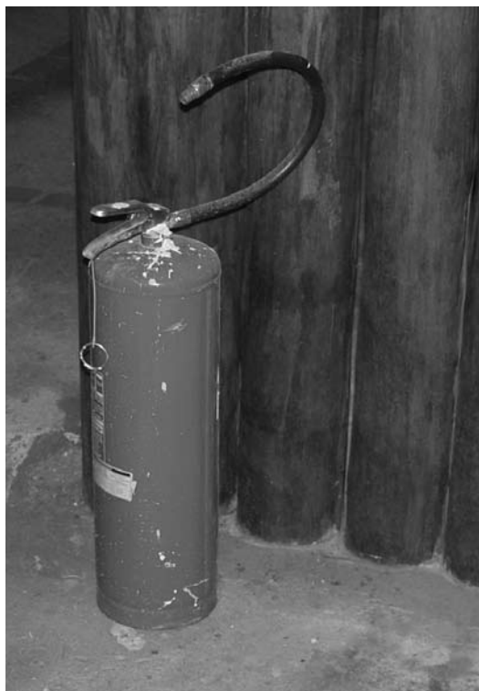
Extintor de incêndio colocado ao chão sem o lacre de segurança indicam que de fato o local não passou por vistoria do Corpo de Bombeiros
