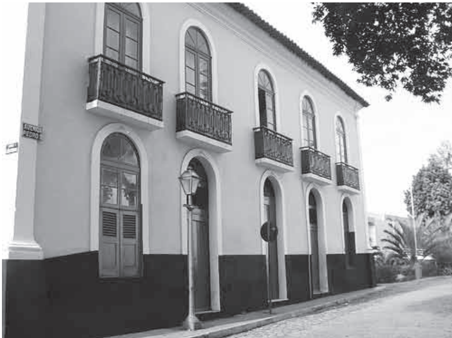
Detalhe de casarão restaurado em São Luís do Maranhão
