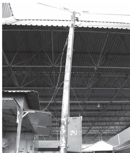
À esquerda, detalhe da gambiarra muito comum nos postes que sustentam a fiação do sistema de monitoramento. No detalhe os fios presos por um simples arame.
