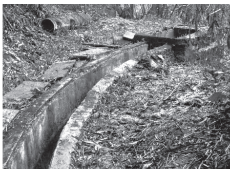
Adutora da Serra - Curvas executadas em Valos de Concreto
