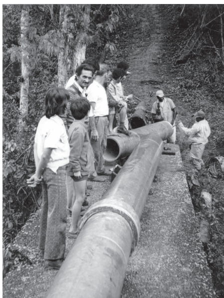
Reparos na Adutora da Serra
